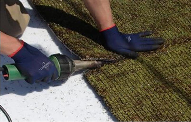
コケマットと排水保護マットは溶着固定します。接着外れでのめくれ、飛散、裏返りが発生しません。
