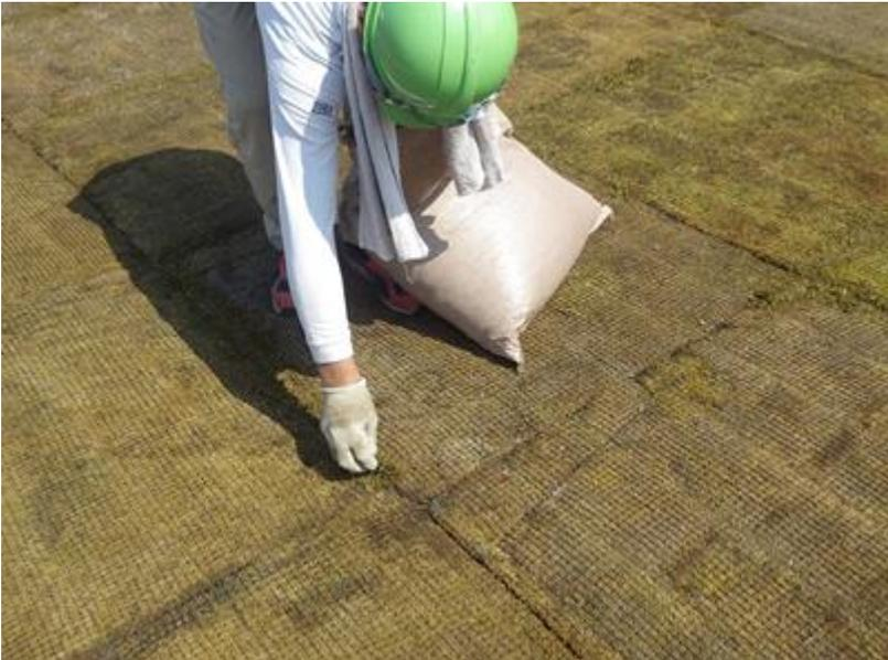
コケマットと排水保護マットは溶着固定します。接着外れでのめくれ、飛散、裏返りが発生しません。
