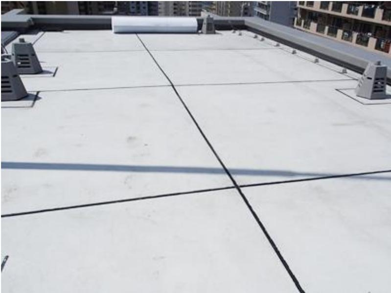
アスファルト露出工法は、水分が残っていると接着不良が起きます。押えモルタル工法・シート防水工法は、多少の湿り状態でも施工できます
